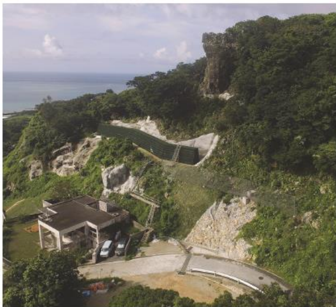
予防治山工事完了後の志喜屋地内現場の様子
