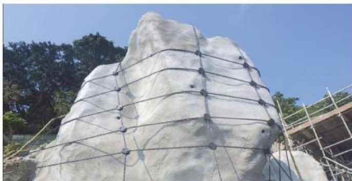
落石防止等のためロープを設置した
